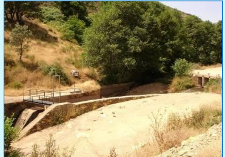
AZÚD SOBRE EL RÍO RUECAS. (CUENCA DEL GUADIANA)
