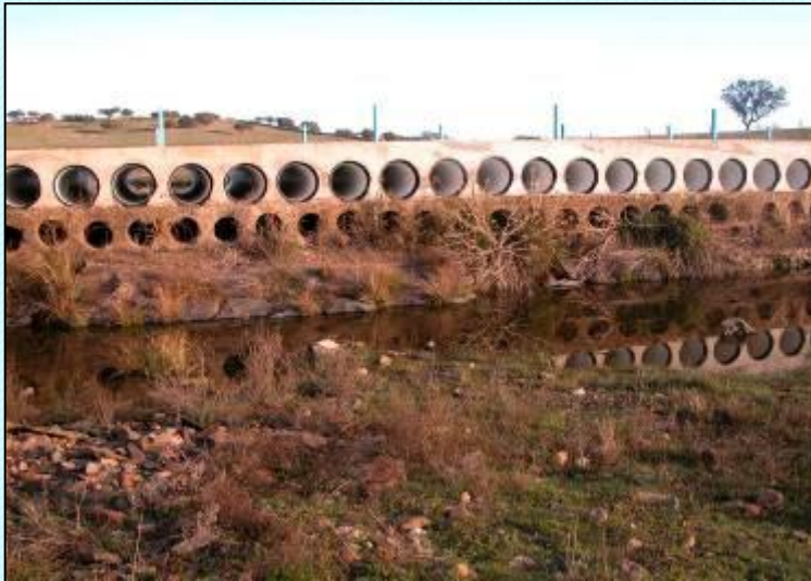
BADÉN SOBRE EL RÍO ZAPATÓN (CUENCA DEL GUADIANA)
